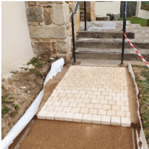
En cours de travaux
